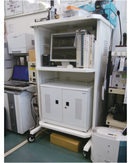
鶴ヶ峰駅 の保管庫 設置例
