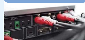
AV機器配線
